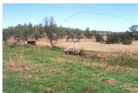
Effluent spray irrigator
